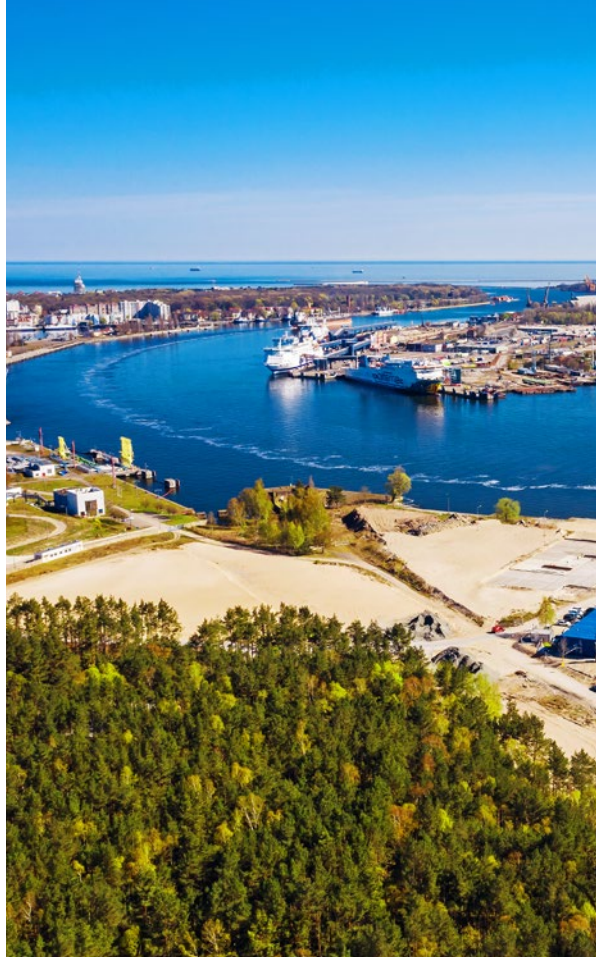
Budowa placu budowy tunelu pod Świną, fot. PORR SA
