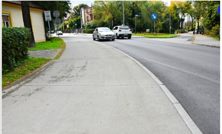
Nawierzchnia wykonana w technologii betonu wałowanego RCC
