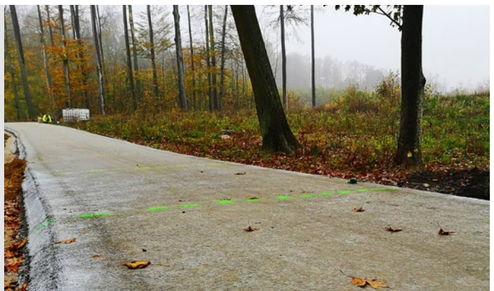
Wygląd nawierzchni po nałożeniu środka hydrofobowego
