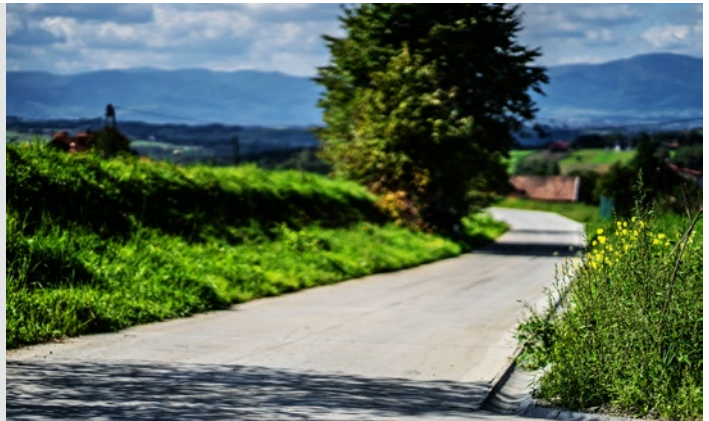
Nawierzchnia wykonana w technologii betonu wałowanego RCC
