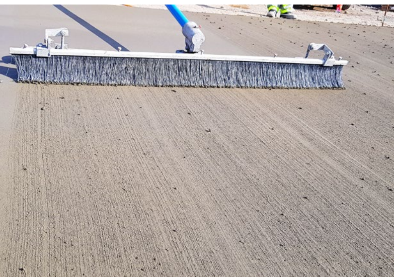
Uszarstnianie nawierzchni (szczotkowanie)
