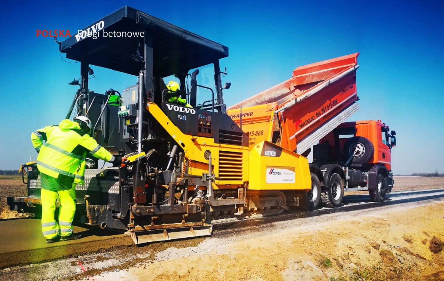
Układanie warstwy stabilizacji C5/6 MPa
