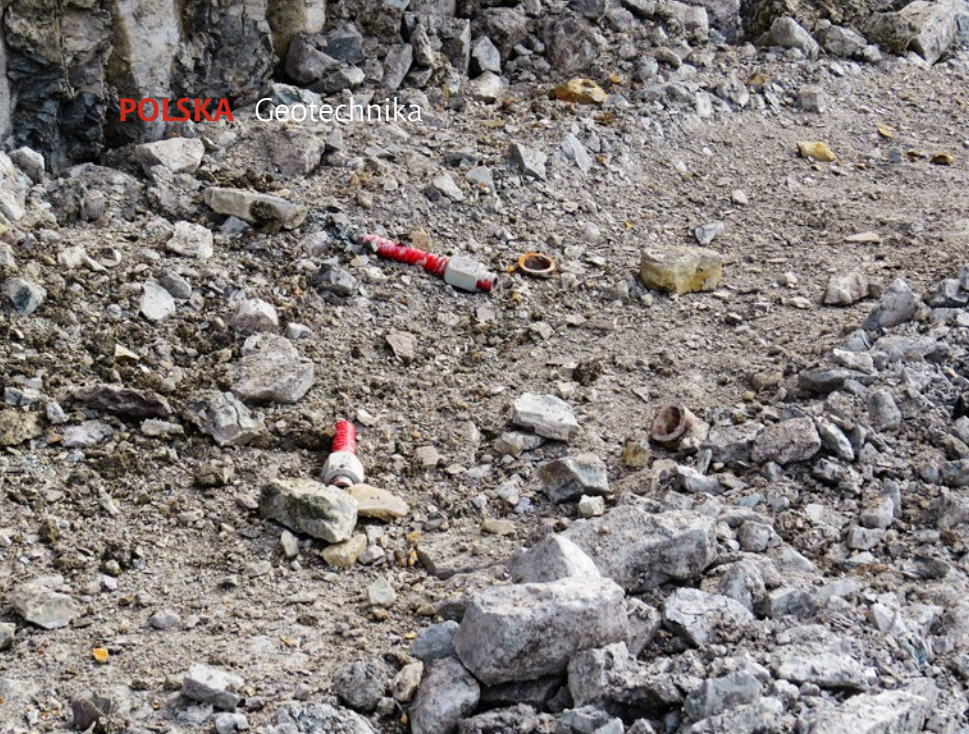
Ryc. 5. Zerwane mikropale kotwiące – fragmenty żerdzi leżące wzdłuż muru i „puste” głowice zakotwień
