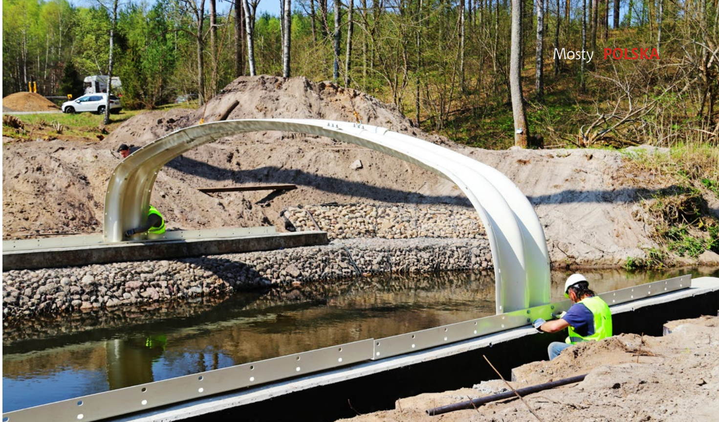
Ryc. 1. Montaż pierwszego modułu konstrukcji typu optemPLATE przez rzekę Korytnicę
