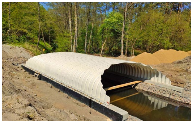
Ryc. 3. Konstrukcja optemPLATE po zakończonym montażu
