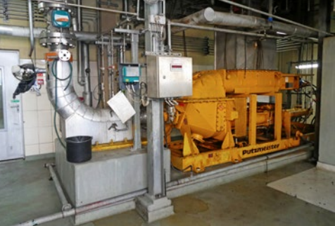
Pompa osadu podsuszonego – wtrysk do pieca
