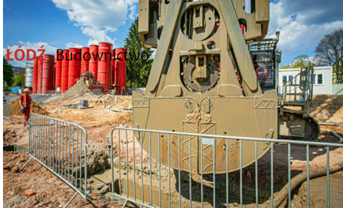
Budowa tunelu średnicowego
