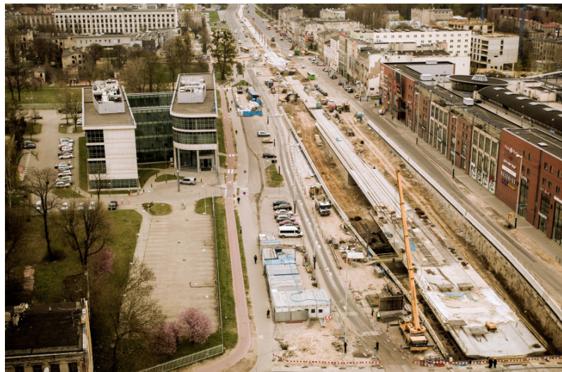
Budowa trasy W-Z
