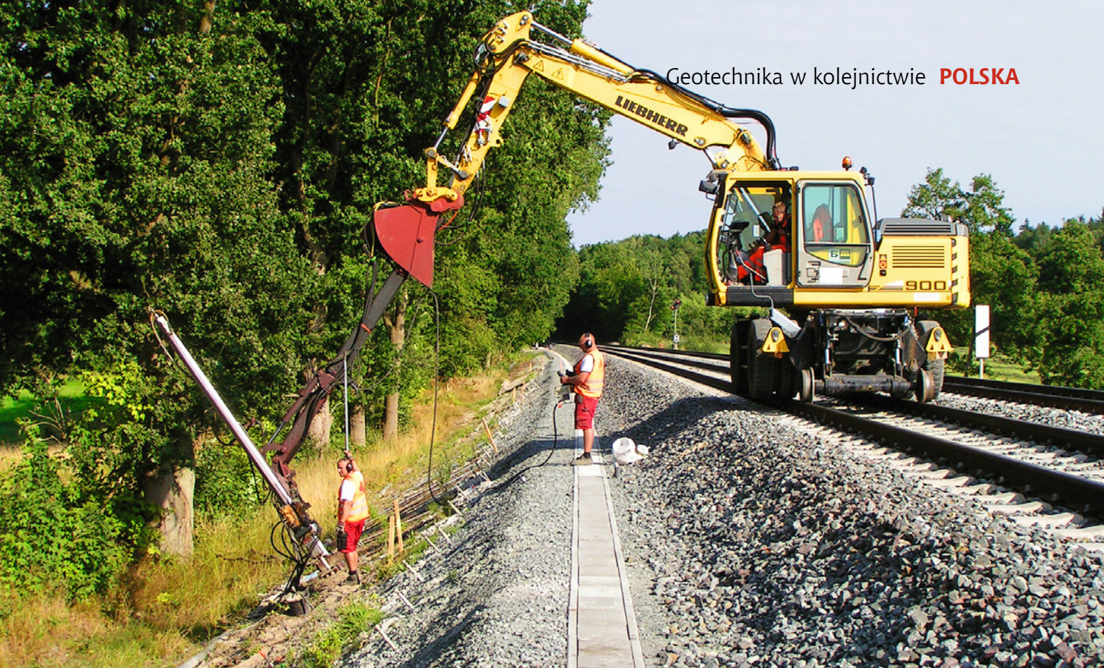
Wzmocnienie nasypu kolejowego przez gwoździowanie prowadzone z toru z zachowaniem ruchu na torze sąsiadującym
