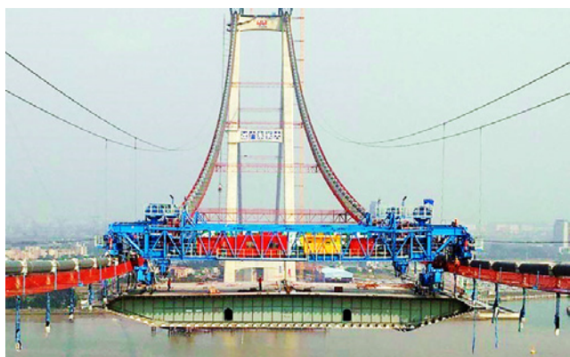
Most Nizhou – montaż sekcji pomostu metodą DLT [28]
