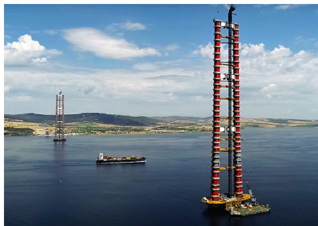
Budowa mostu Çanakkale 1915 [10]
