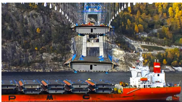
Most Hardanger – montaż sekcji pomostu [Google Map]
