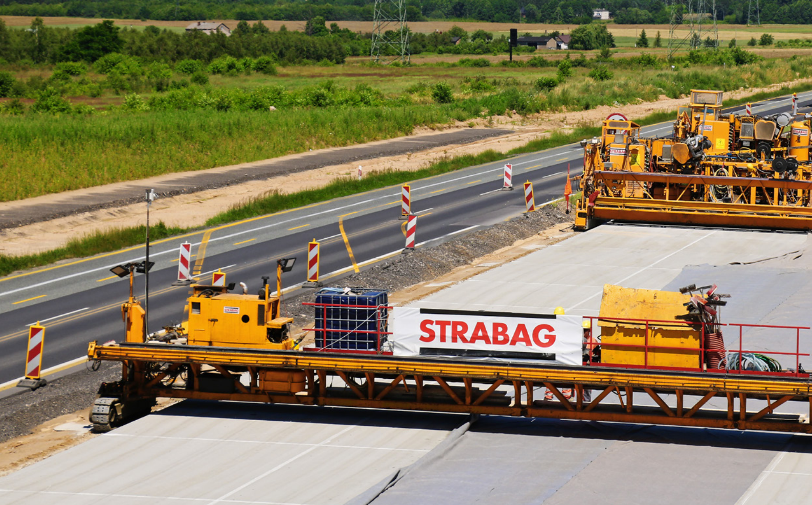
Nawierzchnia betonowa z betonu cementowego C35/45, autostrada A1
