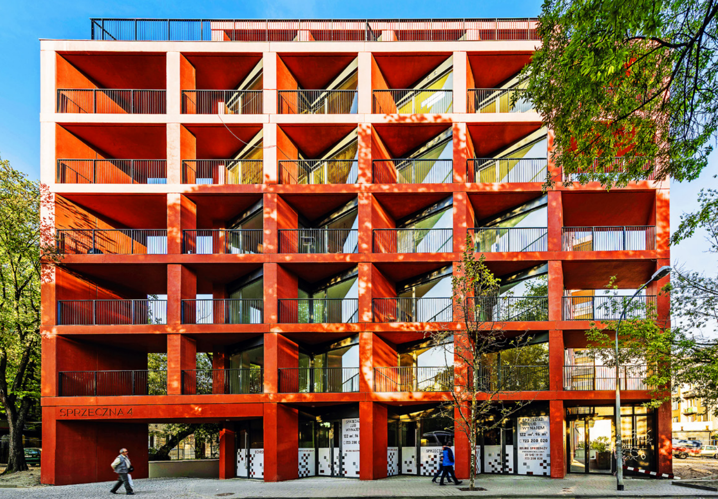
Budynek wielorodzinny przy ul. Sprzecznaj 4 w Warszawie
