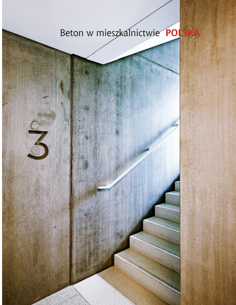
Klatka schodowa w budynku prefabrykowanym, ul. Sprzecza 4 w Warszawie
