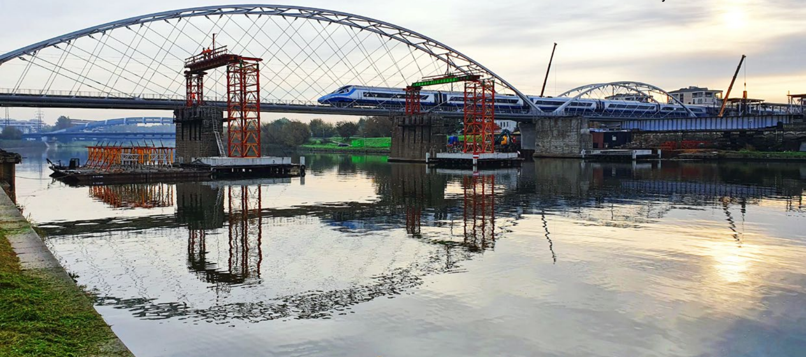
Budowa nowego mostu kolejowego przez Wisłę w Krakowie, fot. PKP PLK S.A.
