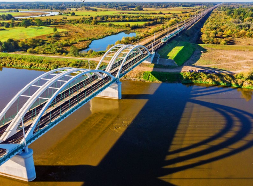
Nowy most przez Bug na odcinku Sadowne – Czyżew w rejonie Małkini, RailBaltica, fot. PKP PLK S.A.
