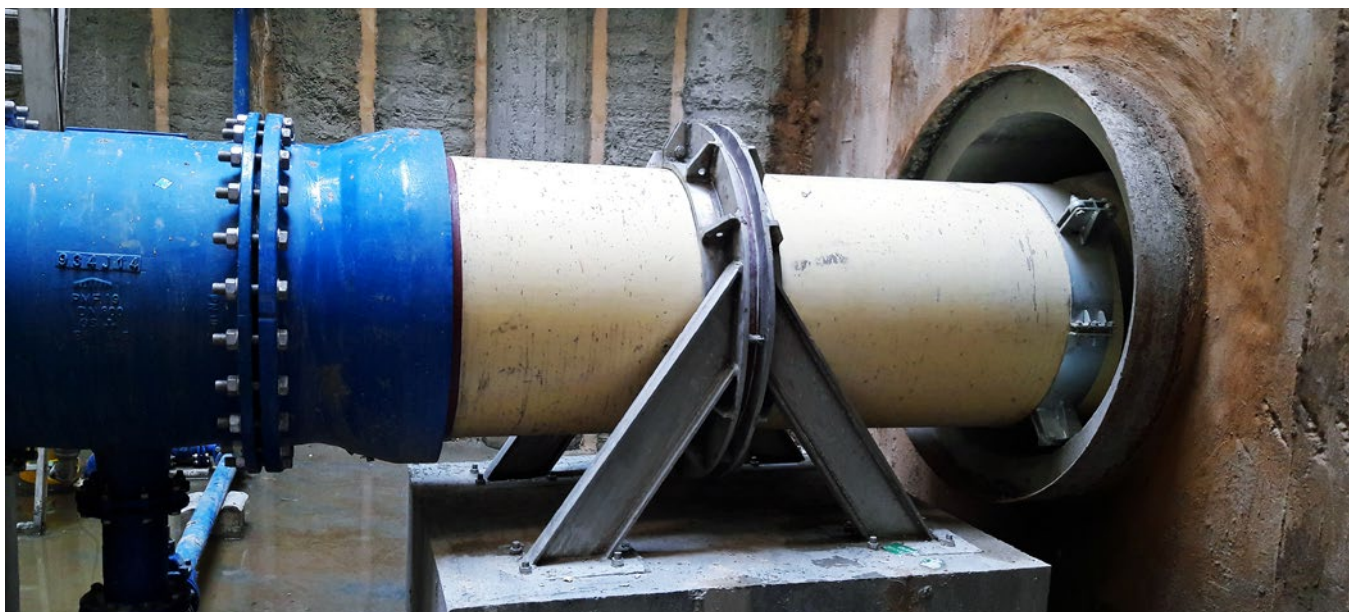
Wlot magistrali wodociągowej DN 800 do przecisku pod Wisłą, fot. R. Potępa, E&C Sp. z o.o.
