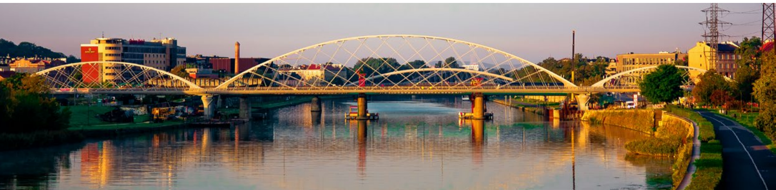
Nowo zbudowany most kolejowy przez Wisłę na linii kolejowej E30 na odcinku Kraków Główny Towarowy – Rudzice, łączący lewobrzeżne Grzegórzki z Podgórzem na prawym brzegu Wisły, fot. Ł. Iwanowicz, Strabag Sp. z o.o.
