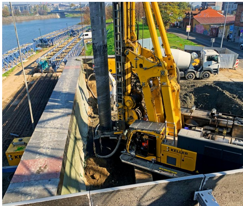
Wiertnica podczas prac przy palisadzie komory nadawczej, fot. P. Szumowicz, E&C Sp. z o.o.
