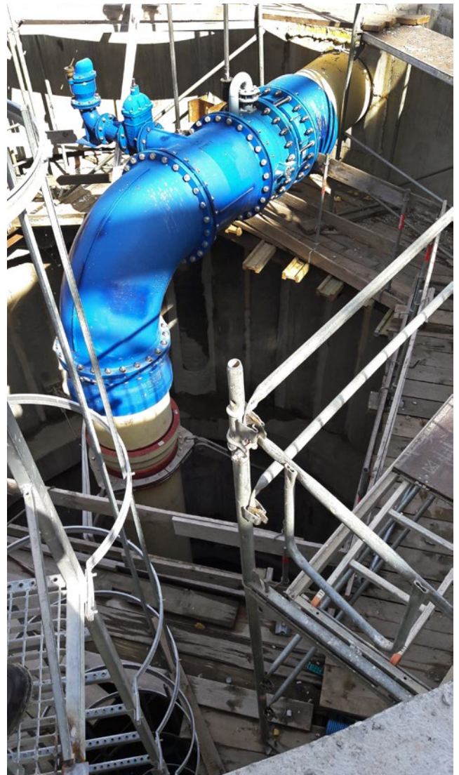
Magistrala wodociągowa DN 800 na wejściu do komory nadawczej, fot. P. Szumowicz, E&C Sp. z o.o.
