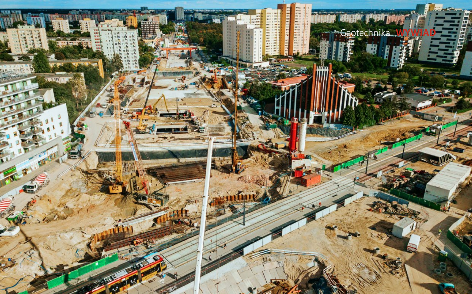
Budowa II linii metra w Warszawie – stacja C21 M2 Bródno
