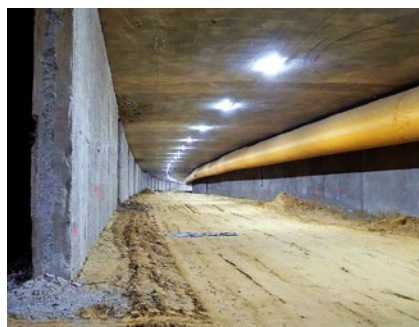
Południowa Obwodnica Warszawy, odcinek A
