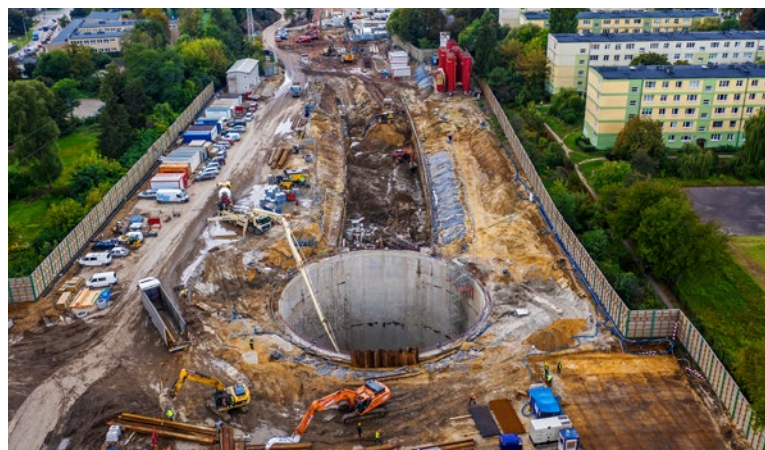
Komora startowa od ul. Stolarskiej, fot. PKP PLK S.A.
