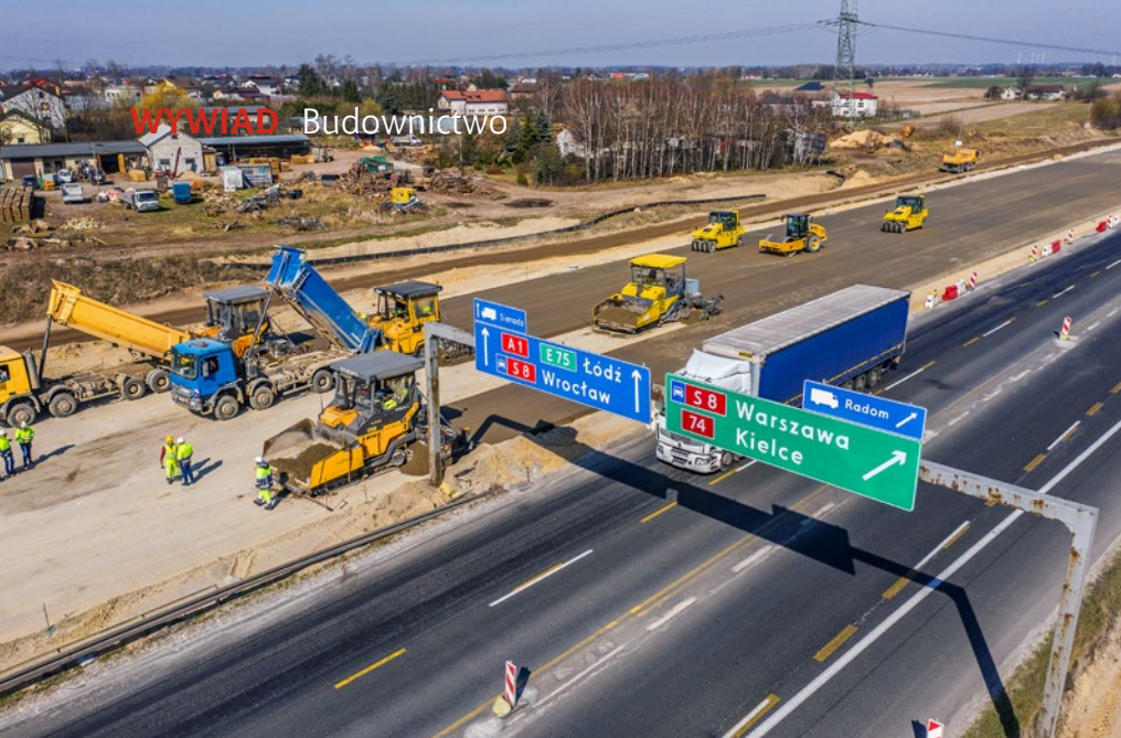
Układanie nawierzchnia na budowie A1 Tuszyn – Piotrków
