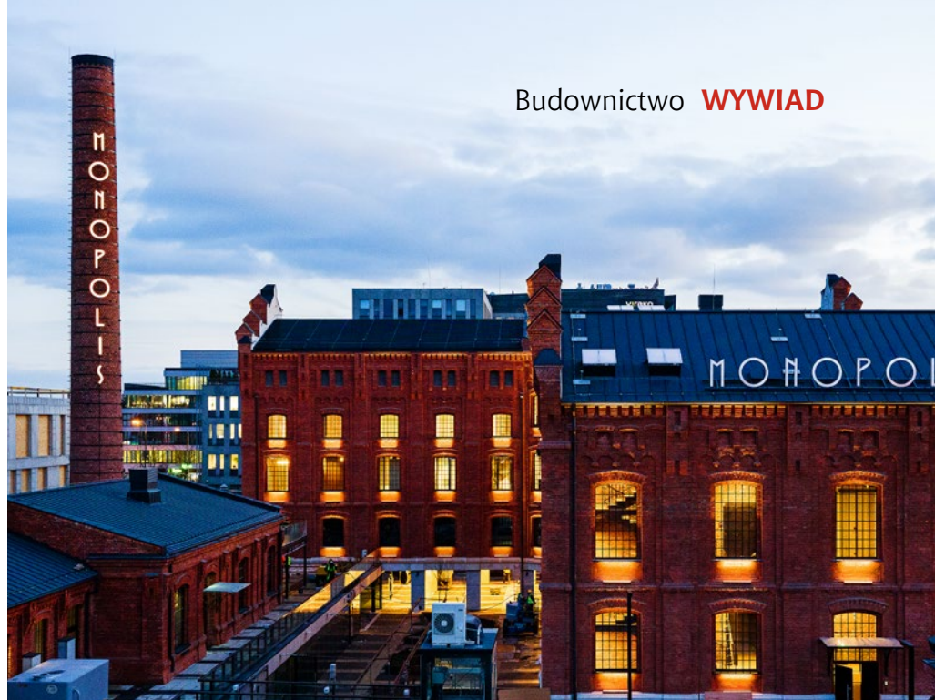
Wielofunkcyjny kompleks Monopolis w Łodzi
