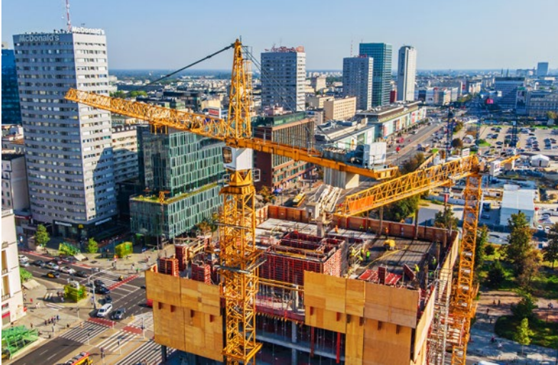
Budowa wieżowca Central Point
