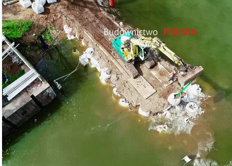
Budowa grody tymczasowej w awanporcie dolnym śluzy Północnej
