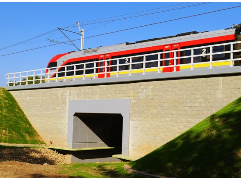
Ryc. 4. Gotowa konstrukcja mostu
