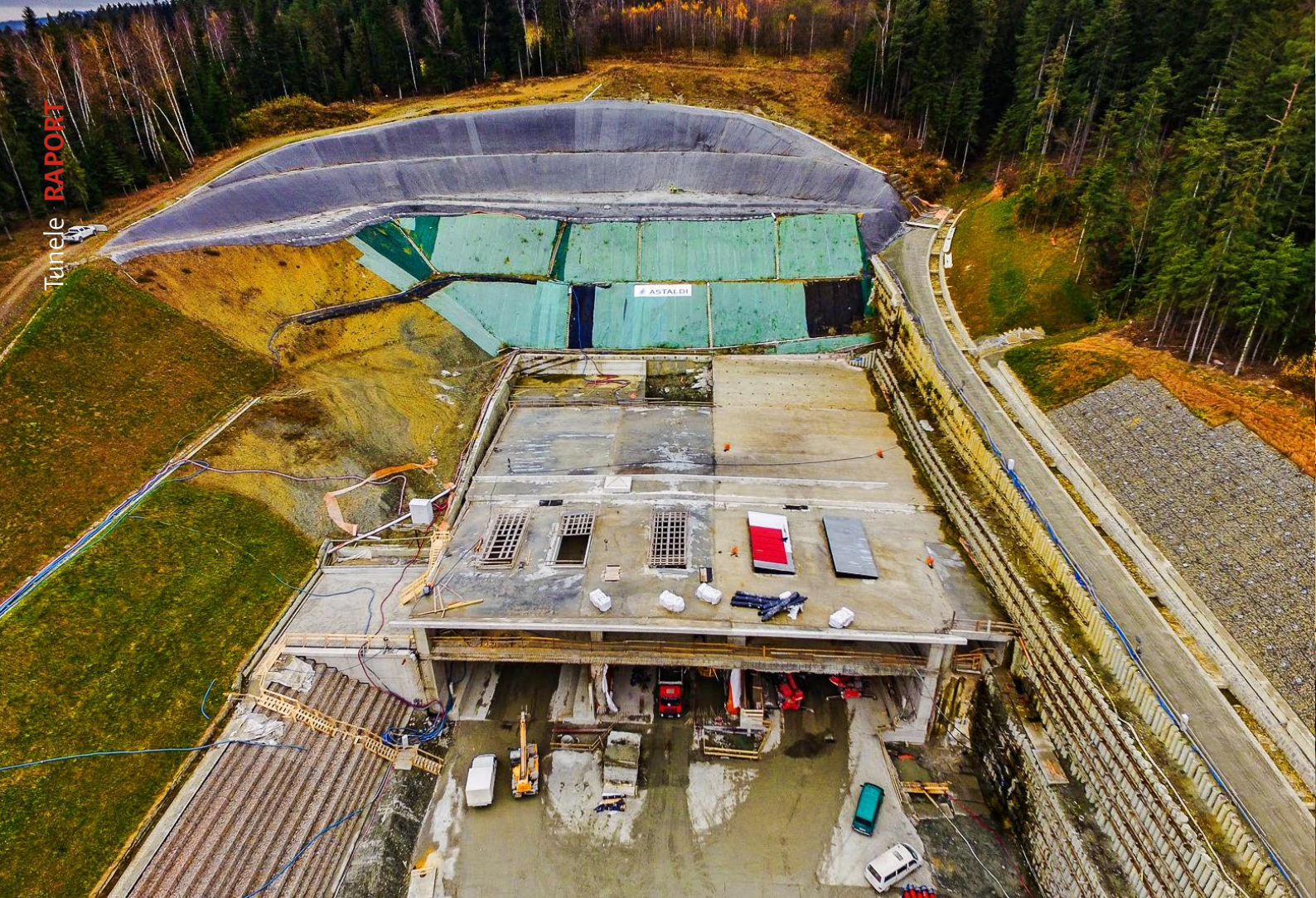
Tunel w ciągu S7, Naprawa – Skomielna Biała, fot. GDDKiA
