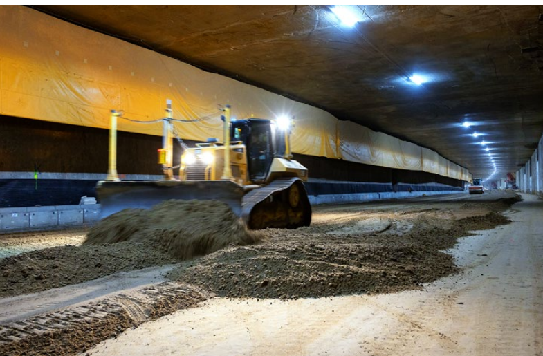
Tunel w ciągu S2, Południowa Obwodnica Warszawy, fot. GDDKiA
