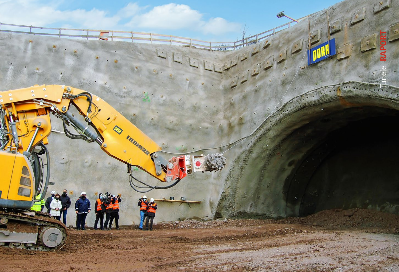
Tunel w ciągu S3, Bolków – Kamienna Góra, fot. PORR SA
