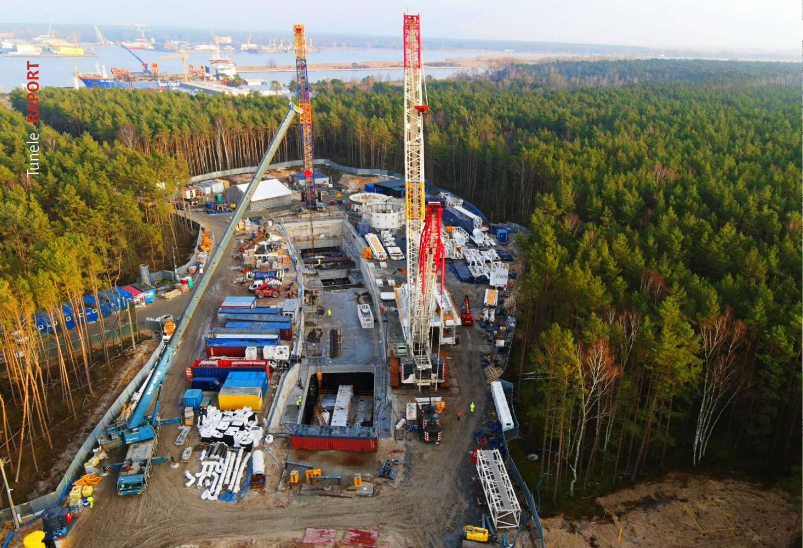
Tunel pod Świną w ciągu DK93, fot. PORR SA
