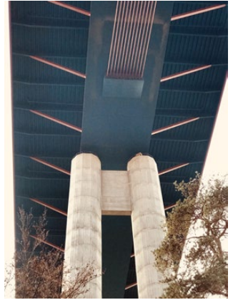
Dźwigar mostu Neckar, fot. K. Dąbrowiecki, 2020
