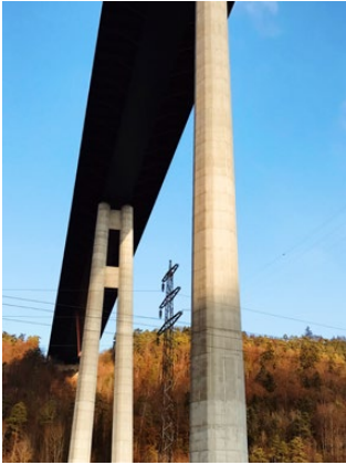
Filary mostu Neckar w Weitingen, fot. K. Dąbrowiecki, 2020
