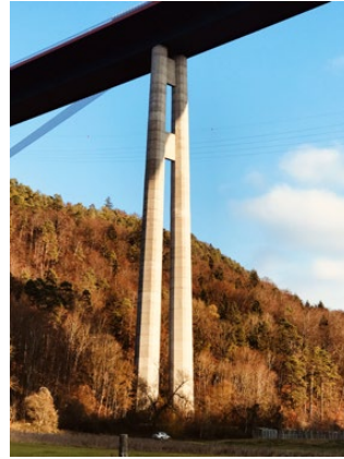
Podwójny filar skrajny mostu Neckar, fot. K. Dąbrowiecki, 2020
