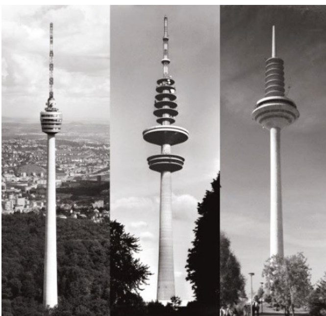
Wieże telekomunikacyjne w Stuttgarcie, Hamburgu i Frankfurcie, źródło: „Structural Engineering International” 2007, Vol. 1
