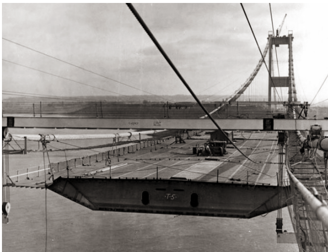
Most Severn, montaż sekcji pomostu, archiwum „Bristol Post” 2018
