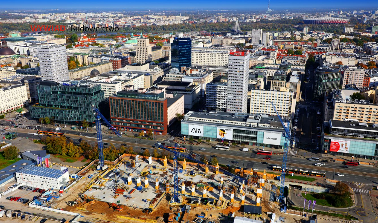
Plac budowy Muzeum Sztuki Nowoczesnej w Warszawie, fot. Warbud SA
