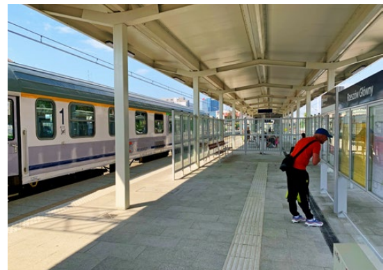
Zmodernizowana stacja Rzeszów Główny
