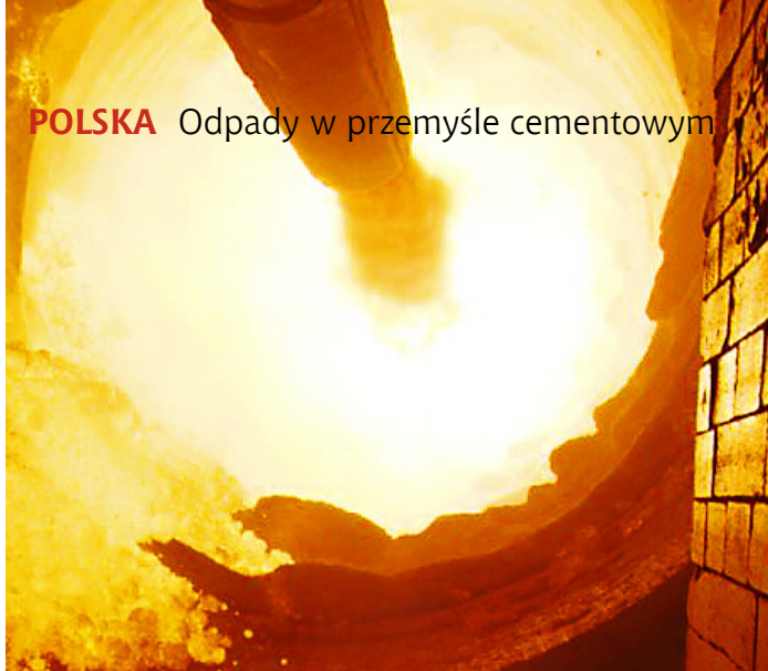
Wnętrze pieca cementowego
