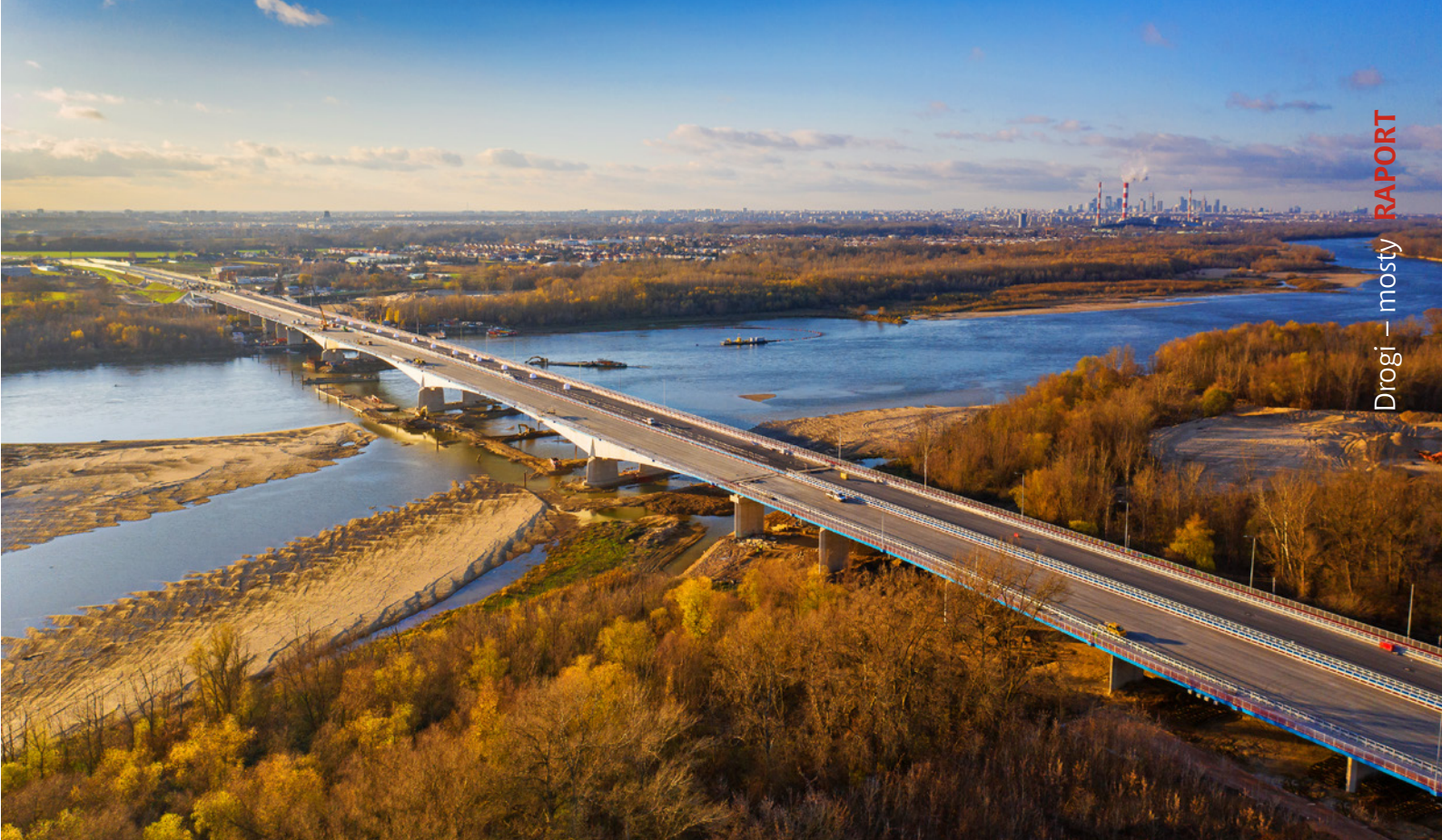
S2, Południowa Obwodnica Warszawy, fot. GDDKiA, fot. K. Nalewajko
