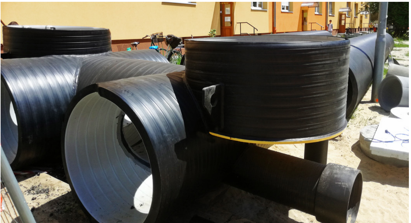
Ryc. 9. Elementy systemu retencyjnego przygotowane do instalacji, fot. Uponsor Infra Sp. z o.o.
