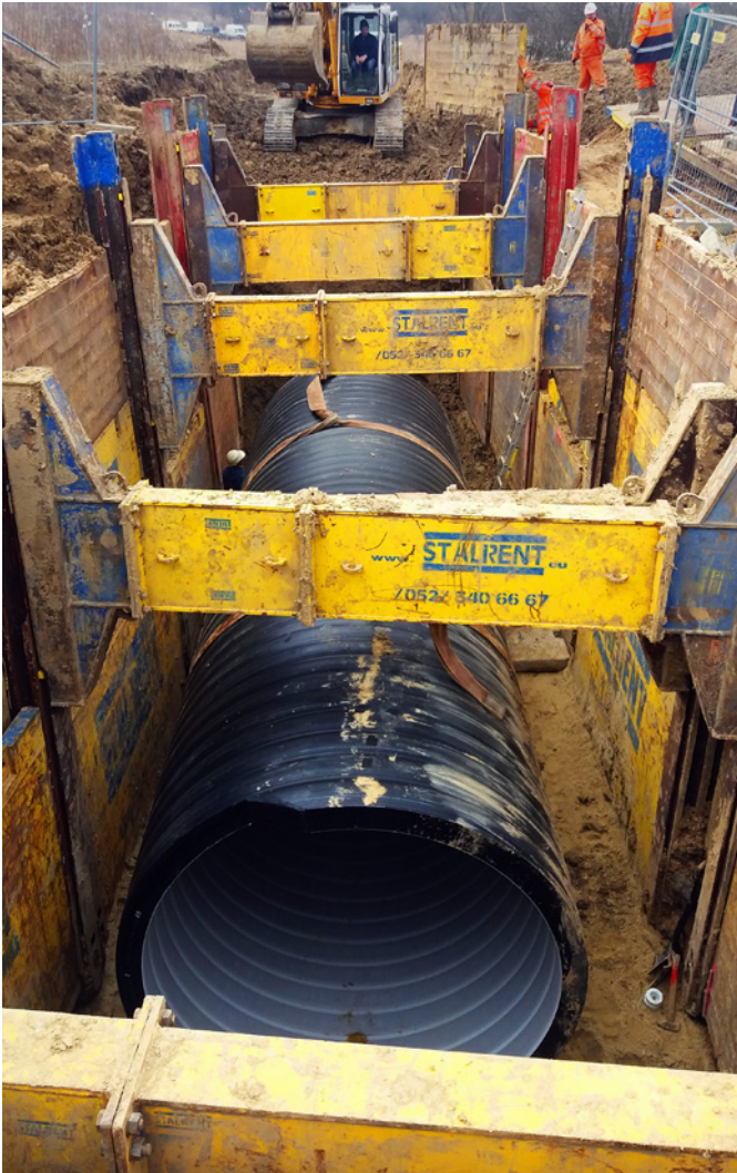
Ryc. 8. Montaż elementów kanału retencyjnego, fot. Uponsor Infra Sp. z o.o.
