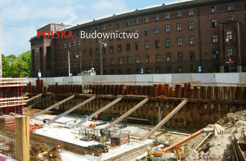
Budowa gmachu Sądu Rejonowego Wrocław-Fabryczna
