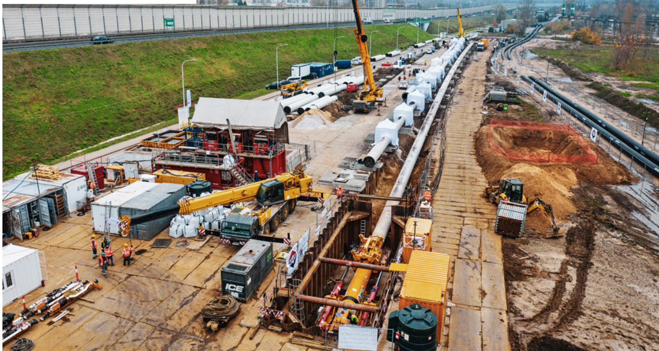
Budowa kolektora awaryjnego pod dnem Wisły do Oczyszczalni Ścieków „Czajka” w Warszawie
