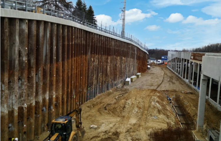
Budowa konstrukcji oporowej, market budowlany Leroy Merlin w Wieliczce
