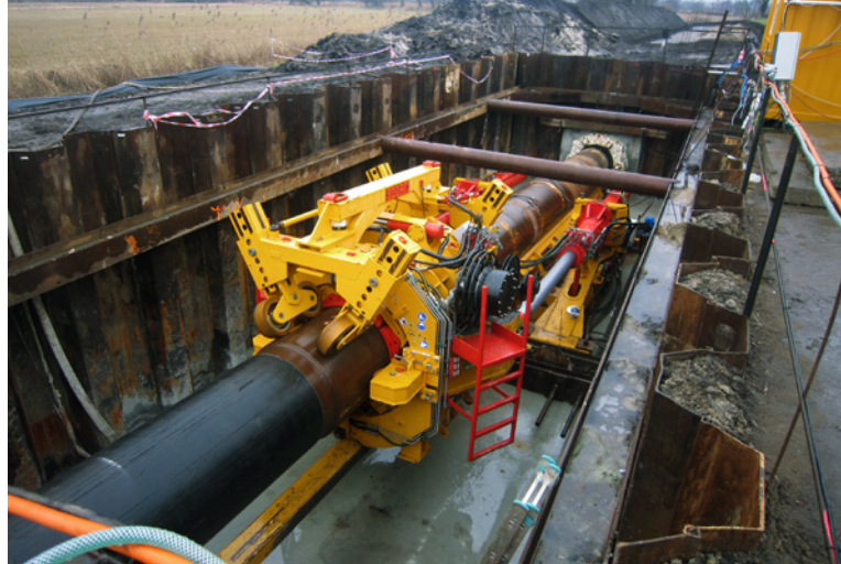
Budowa gazociągu Pogórska Wola – Tworzeń o średnicy DN 1000
