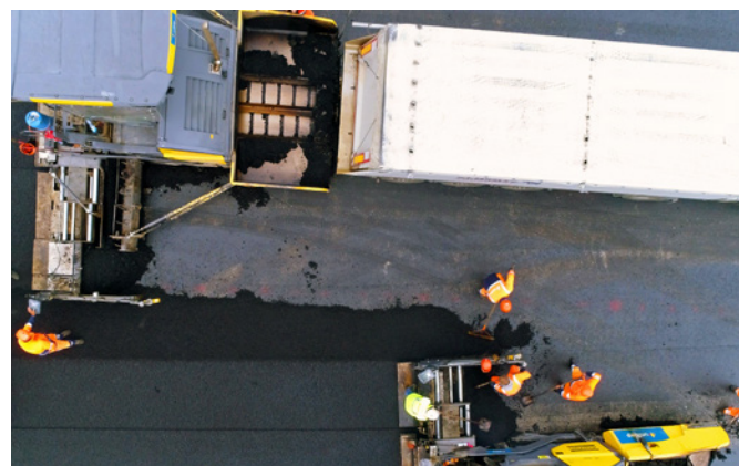
Budowa węzła drogowego w Porosłach w powiecie białostockim. Układanie nawierzchni MODBIT HiMA. Wyprowadzenie ruchu w kierunku S8 dla inwestycji będącej przedmiotem współpracy z dostawcą w ramach programu „15 inwestycji z okazji 15-lecia LOTOS Asfalt”
