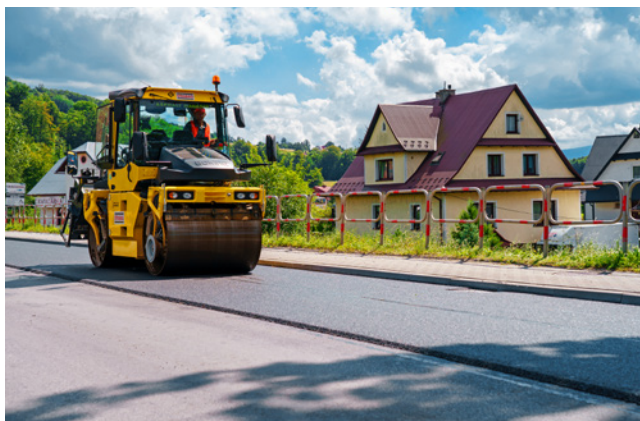
Zastosowana na warstwę ścieralną w ciągu DW968 w miejscowości Kasinka Mała cienka warstwa nawierzchni z mieszanki mineralno-asfaltowej typu BBTM 8A z asfaltem MODBIT 45/80-80 HiMA spełnia kryteria tzw. cichych nawierzchni
