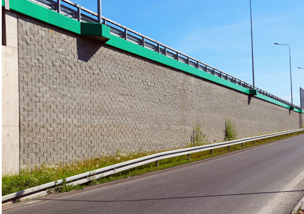
Przy obiektach inżynierskich zastosowano różne technologie oparte na gruncie zbrojonym
