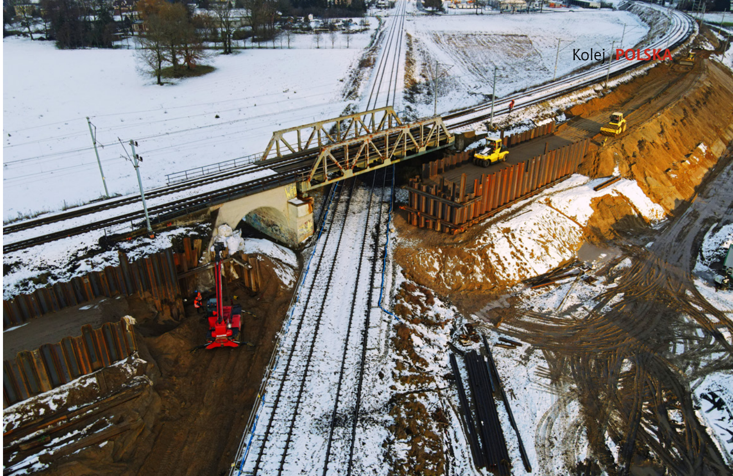
Budowa bajpasu kolejowego na LK351
