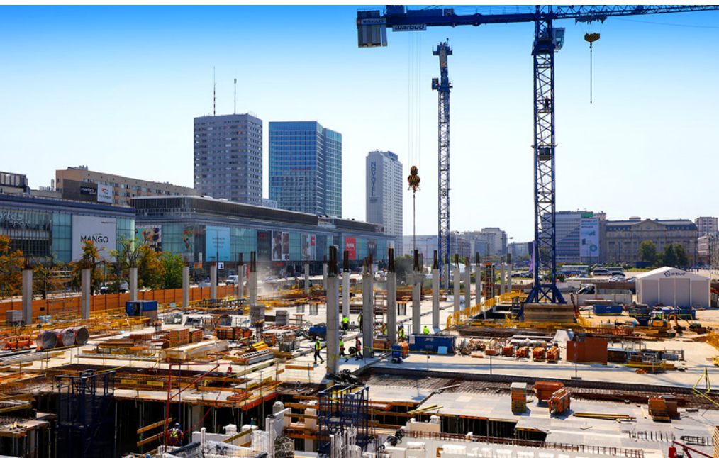
Plac budowy Muzeum Sztuki Nowoczesnej w Warszawie
