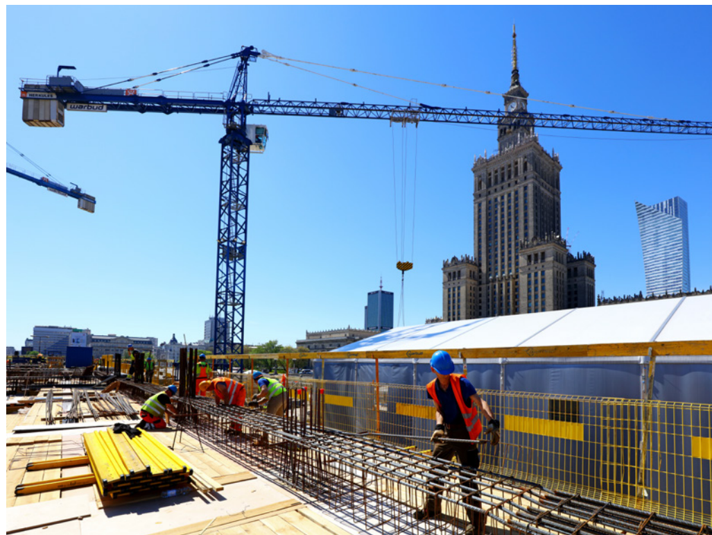
Budowa Muzeum Sztuki Nowoczesnej w Warszawie
