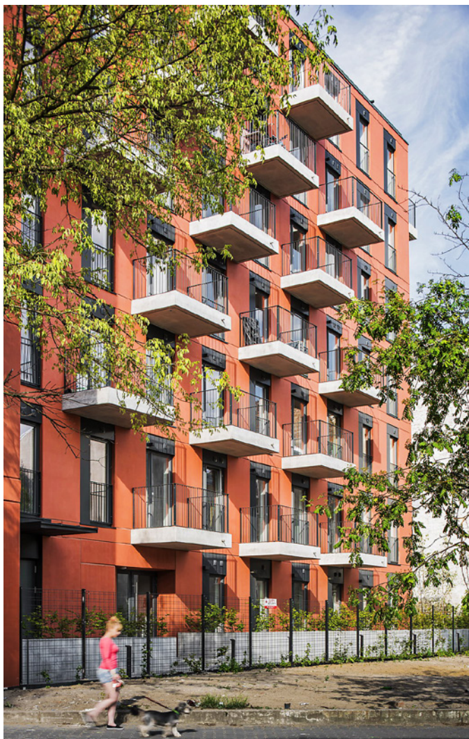
Budynek wielorodzinny przy ul. Sprzecznej 4 w Warszawie
