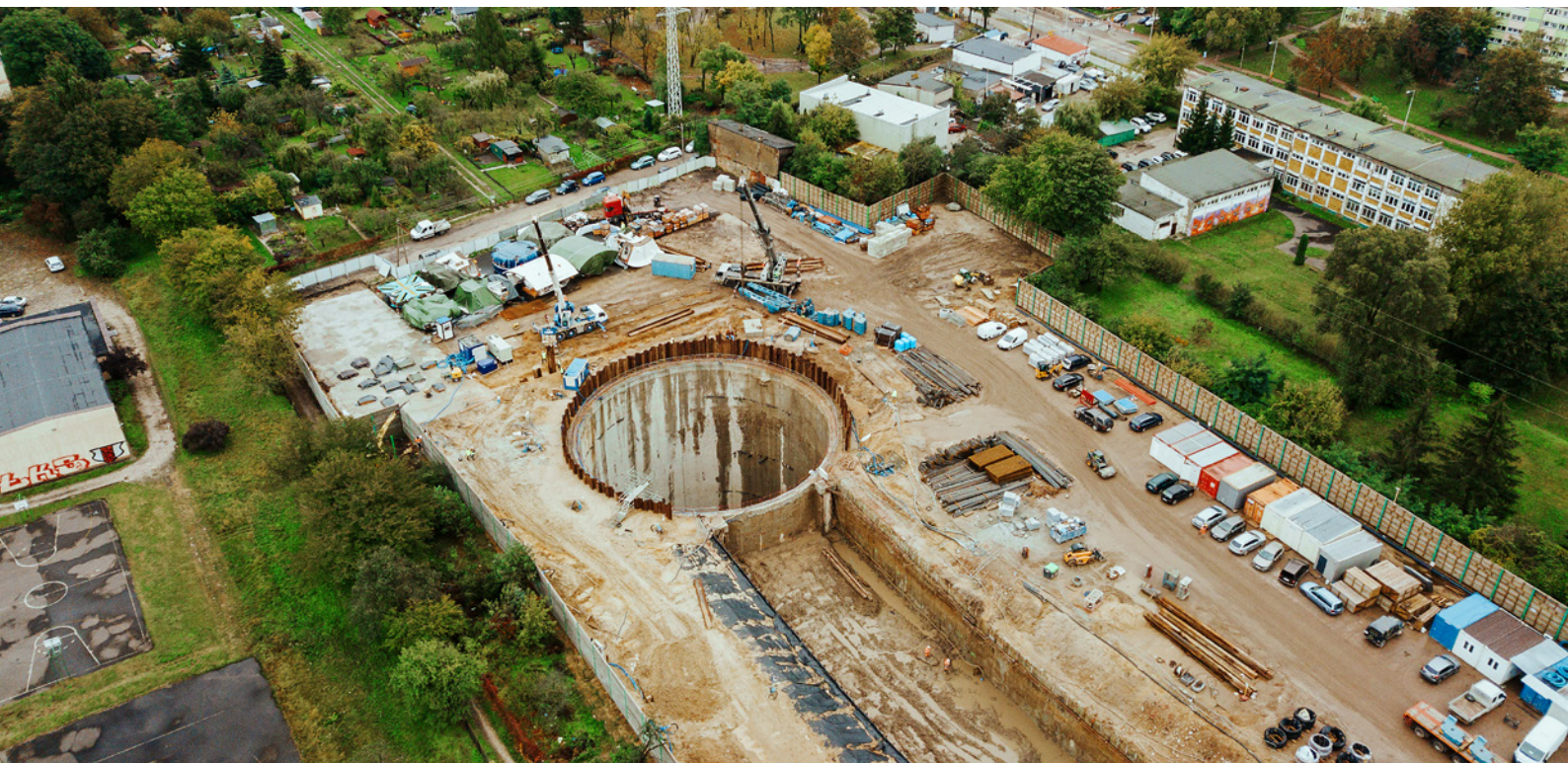
Plac budowy komory Odolanowskiej dla dużej tarczy TBM o średnicy 13,03 m w Łodzi, fot. Soletanche Polska Sp. z o.o.
