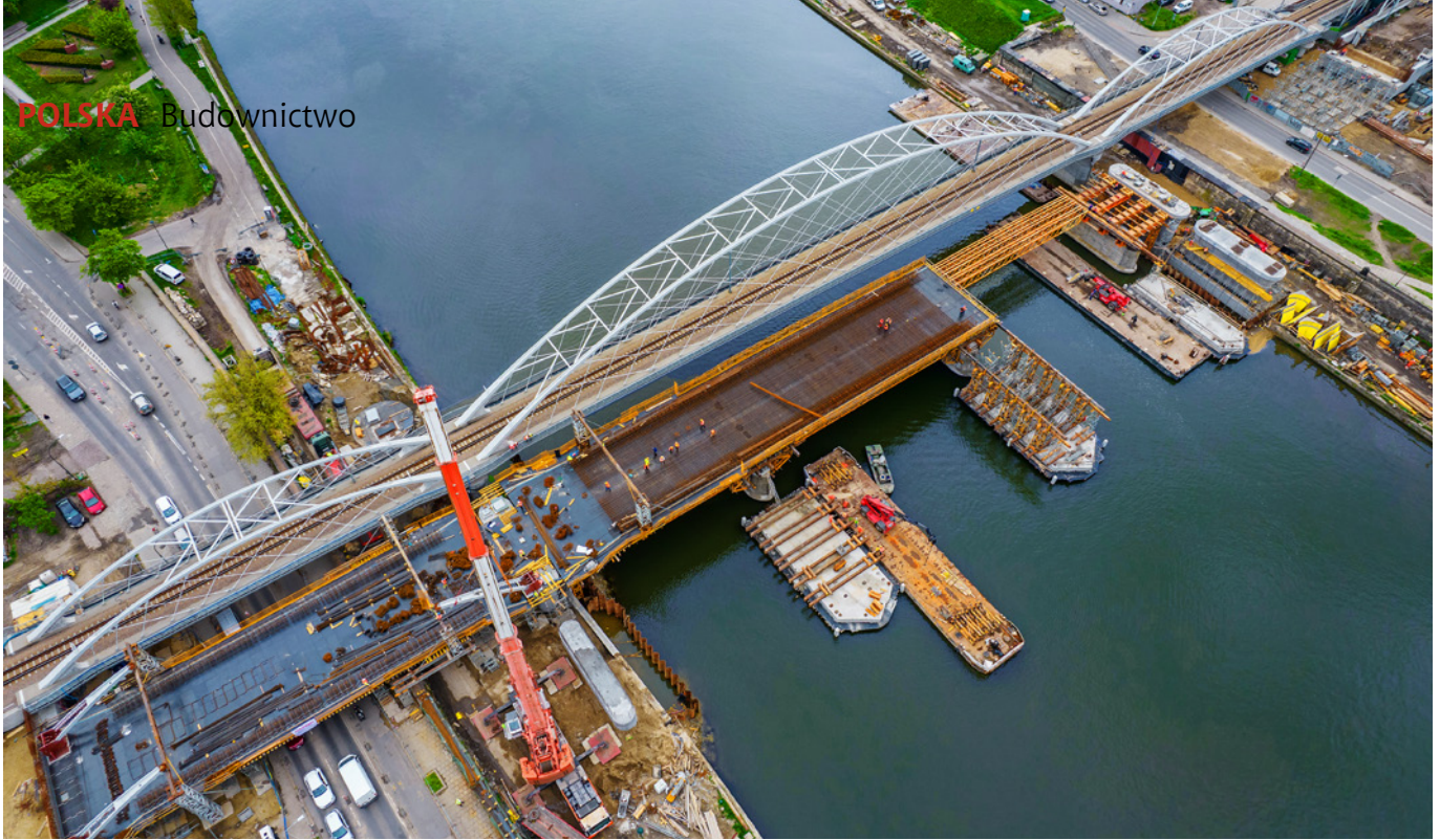
Budowa mostów przez Wisłę na linii kolejowej E30, fot. Strabag Sp. z o.o.
