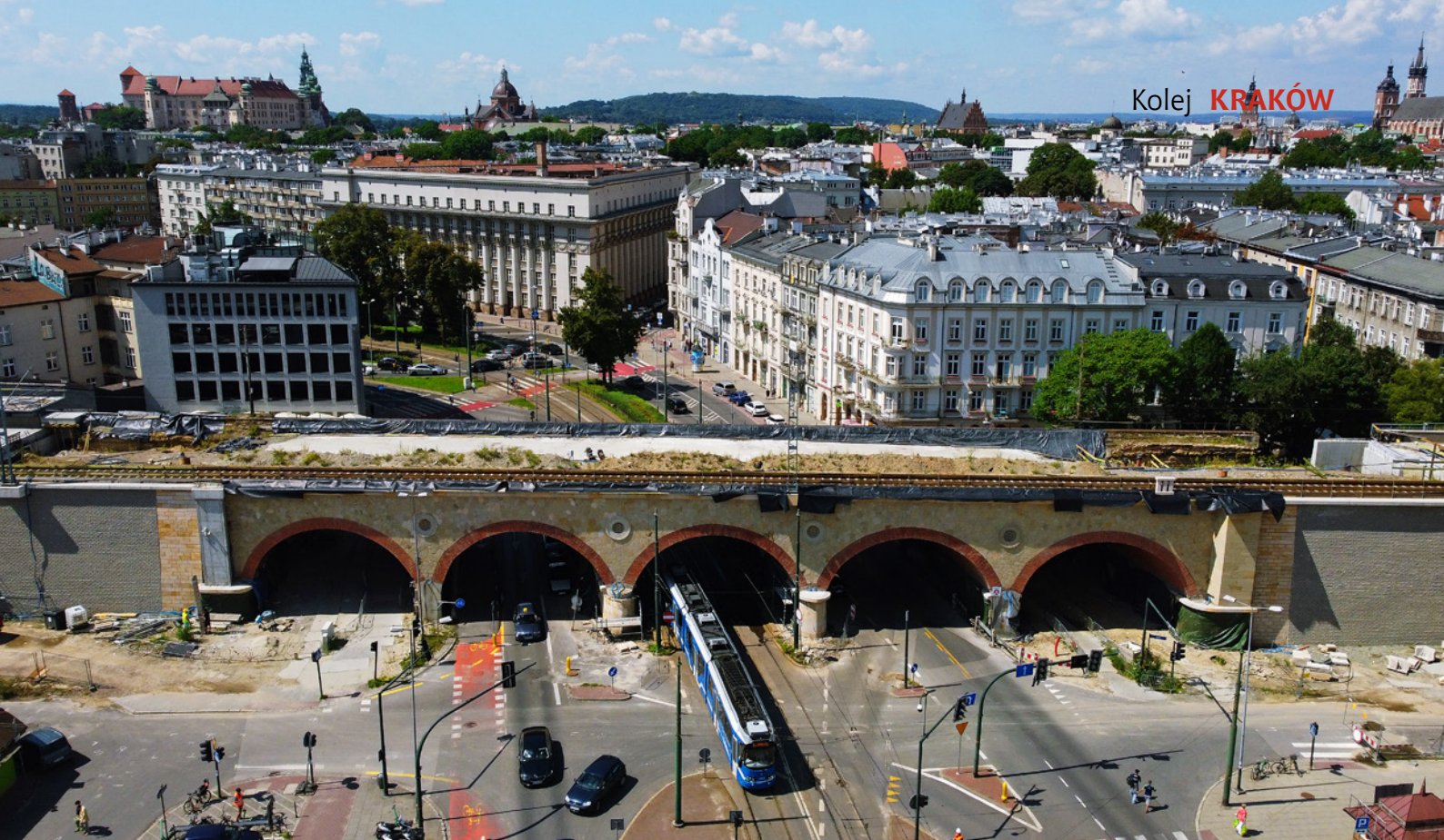
Zabytkowy wiadukt nad ul. Grzegorzeczką w Krakowie, fot. P. Hamarnik, PKP PLK SA
