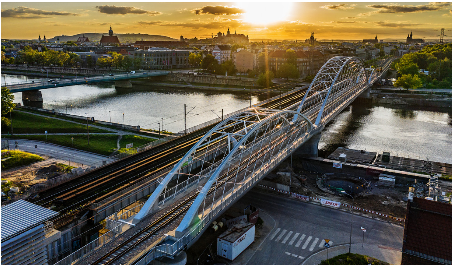
Budowa mostów kolejowych przez Wisłę w Krakowie, fot. STRABAG Sp. z o.o.
