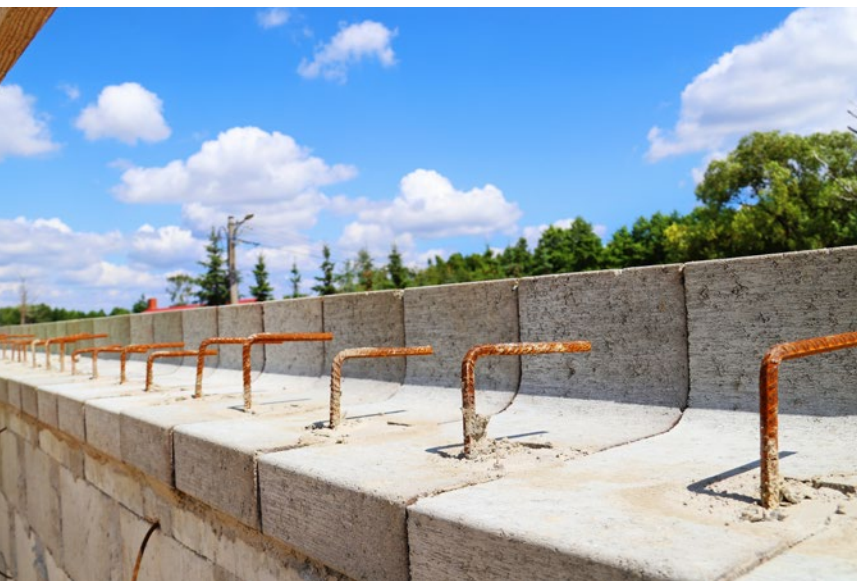
Zastosowanie kapy w kształcie litery T przyniosło znaczne oszczędności
