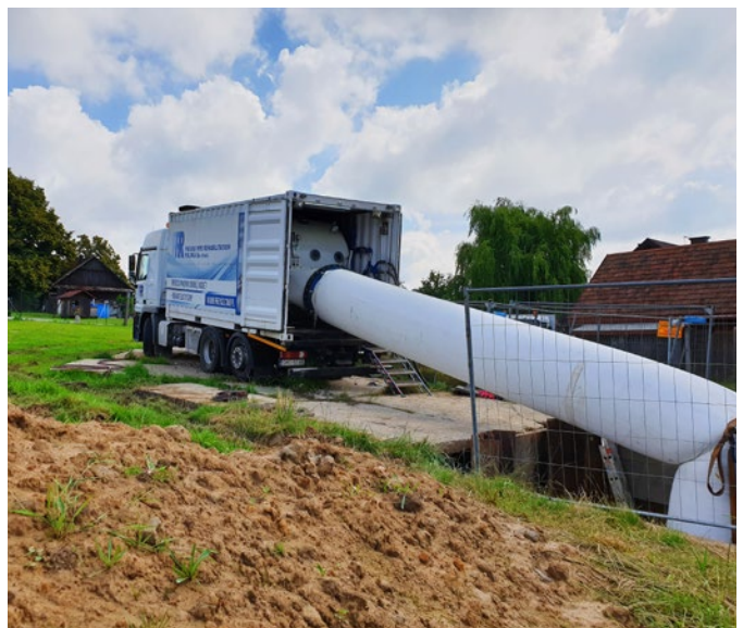
Utwardzanie remontowanego odcinka
