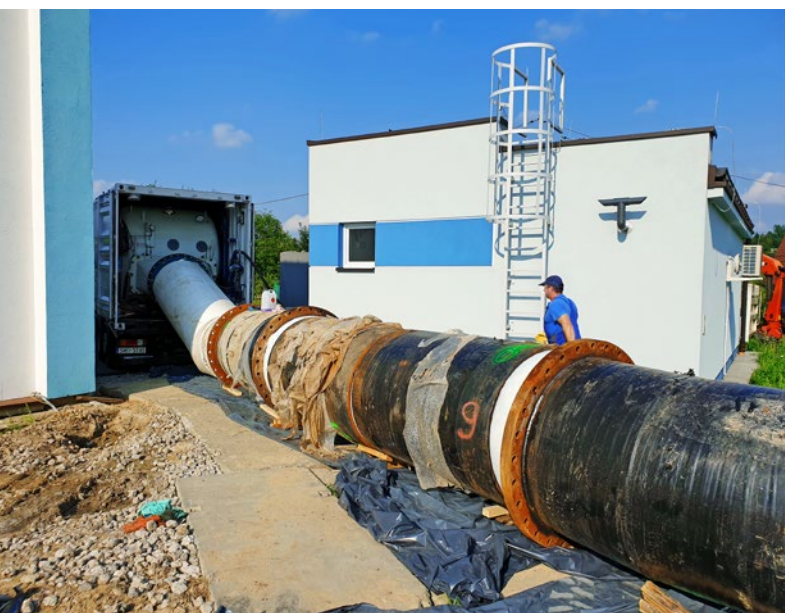
Przebieg renowacji w rejonie komory KP-3
