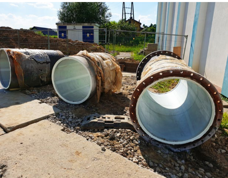
Odcinki przewodu poddane renowacji
