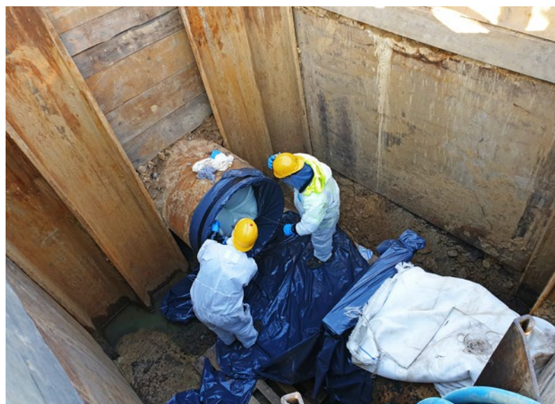
Wciąganie rękawa do rurociągu
