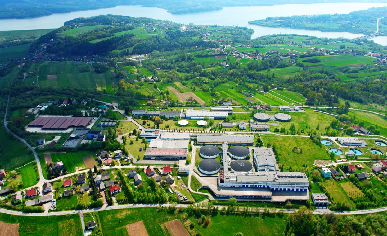
Zakład Uzdatniania Wody Raba w Dobczycach
