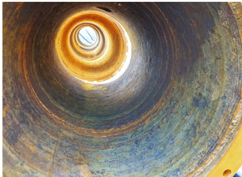
Fragment rurociągu po czyszczeniu
