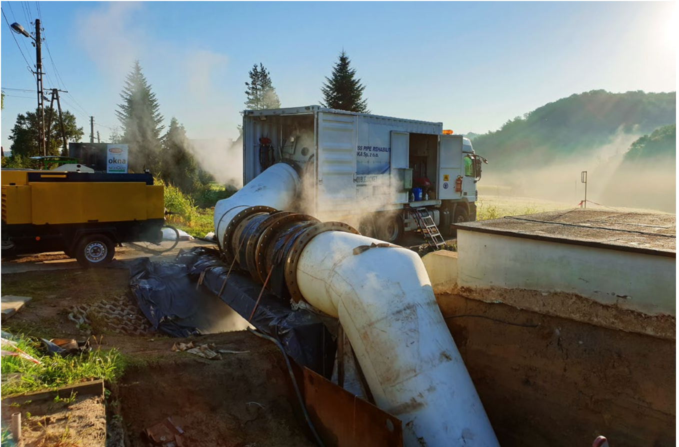
Parowanie remontowanego odcinka
