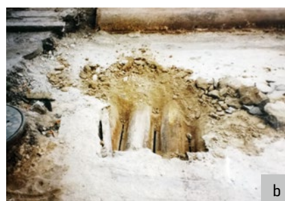
Ryc. 6. Przykład mostu drogowego z pomostem niewspółpracującym z kształtowników Zoresa, dla którego opracowano projekt, a następnie wykonano wzmocnienie pomostu przy udziale autora artykułu: a) widok ogólny mostu przed remontem, b) wykonana odkrywka mająca na celu ocenę stanu technicznego kształtowników Zoresa, c) widok części pomostu w strefie kap chodnikowych wraz z uszkodzeniami korozyjnymi
