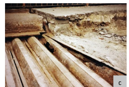
Ryc. 6. Przykład mostu drogowego z pomostem niewspółpracującym z kształtowników Zoresa, dla którego opracowano projekt, a następnie wykonano wzmocnienie pomostu przy udziale autora artykułu: a) widok ogólny mostu przed remontem, b) wykonana odkrywka mająca na celu ocenę stanu technicznego kształtowników Zoresa, c) widok części pomostu w strefie kap chodnikowych wraz z uszkodzeniami korozyjnymi
