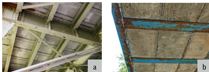
Ryc. 3. Przykłady pomostów niewspółpracujących, wykonanych z płyt żelbetowych, ułożonych bezpośrednio na elementach konstrukcyjnych mostu stalowego: a) most drogowy przez Odrę w Ścinawie w ciągu DK36, b) kładka dla pieszych zlokalizowana na os. Gagarina w Radomiu
