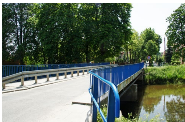
Ryc. 10. Widok ogólny mostu po ponad 30 latach eksploatacji od czasu jego remontu
