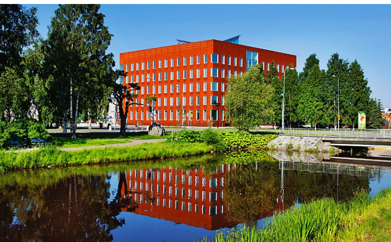
Oulu w Finlandii. Architekt Juha Pasanen zaprojektował ten budynek, twierdząc, że stal Weathering to jedyny materiał elewacyjny, który przetrwa 100 lat bez konserwacji
