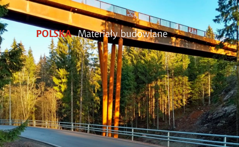
Kładka dla pieszych Kuusijärvi w gminie Vantaa w Finlandii, w pobliżu jeziora Kuusijärvi, zbudowana ze stali SSAB Weathering 355
