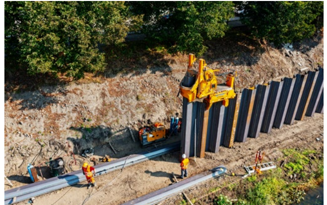
Ścianka szczelna z grodzic stalowych w Słubicach, pograżana statycznie i dynamicznie maszyną Kovan WP150
