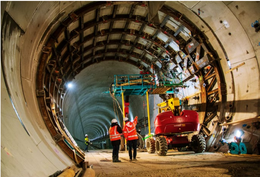
Tunel w Świnoujściu, fot. M. Grzeszczuk, GDDKiA
