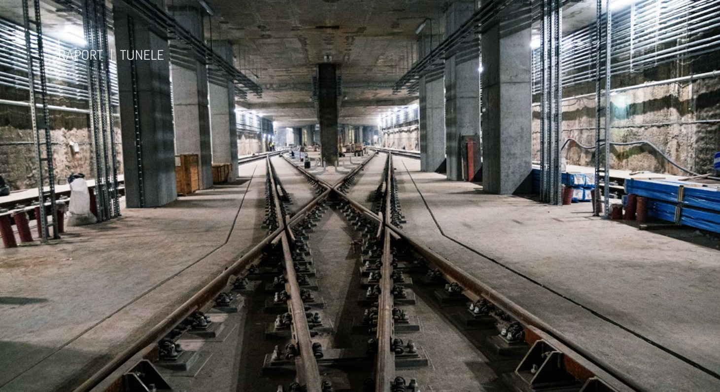
Tunel metra w Warszawie, fot. Metro Warszawskie Sp. z o.o.
