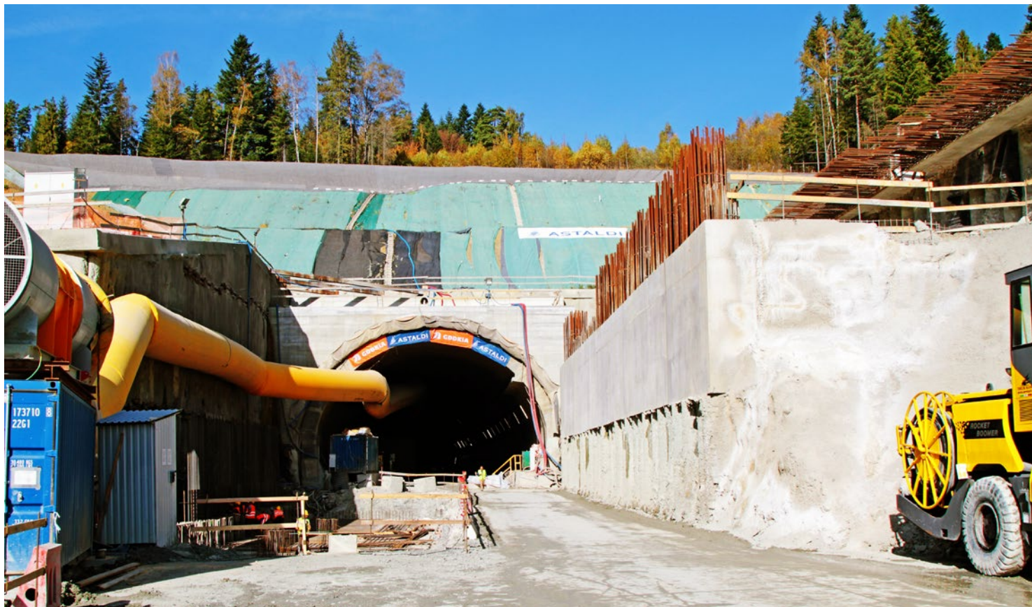
Tunel w ciągu zakopianki pod Luboniem Małym, fot. nbi media
