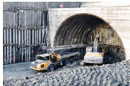
Wyprofilowane skarpy przed rozpoczęciem drążenia tuneli w Naprawie oraz wykonywanie portalu południowego
