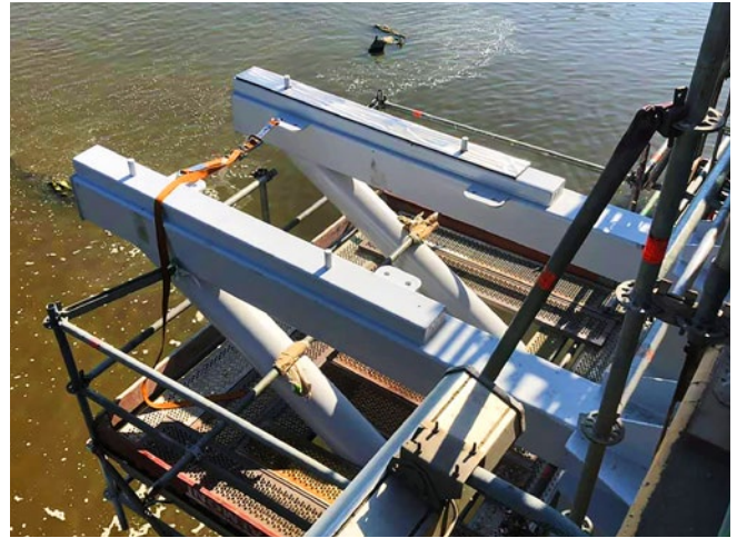
Ryc. 3. Wspornik stalowy mocowany do istniejącej podpory
