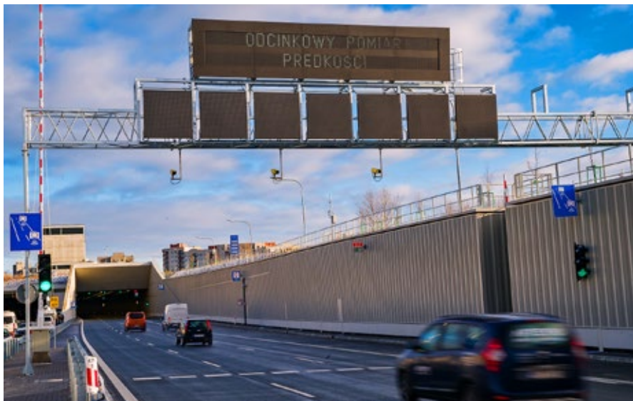
Wjazd do tunelu pod Ursynowem w ciągu Południowej Obwodnicy Warszawy, fot. K. Nalewajko, GDDKiA
