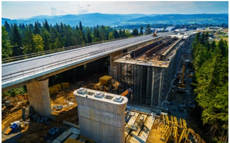
Budowa drogi ekspresowej S7, fot. Daniel Jędzura, Adobe Stock
