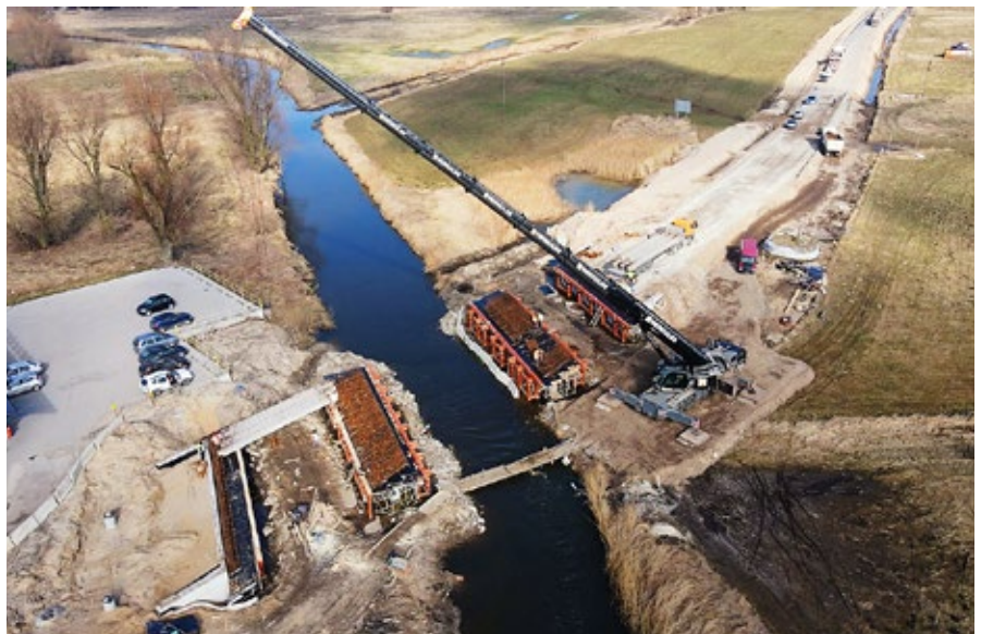
Budowa mostu w Bieżuniu w ciągu drogi wojewódzkiej nr 541 na północy Mazowsza, fot. MZDW w Warszawie
