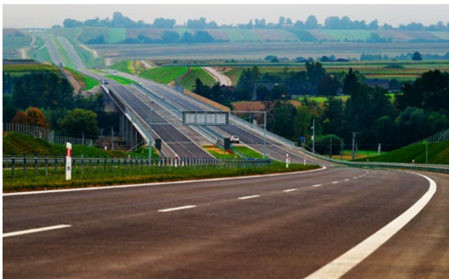
S7 Szczepanowice – Widoma, fot. K. Nalewajko, GDDKiA
