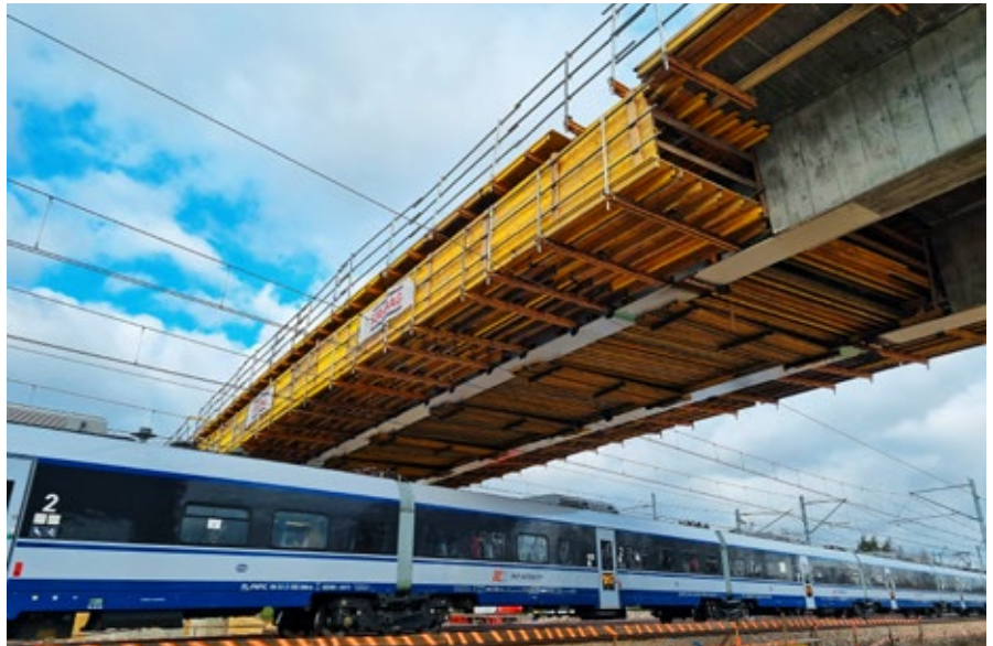
Budowa wiaduku na zachodniej obwodnicy Grodziska Mazowieckiego, fot. MZDW w Warszawie
