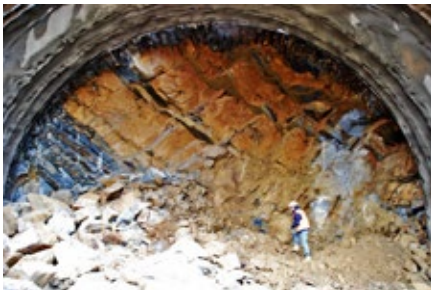
Przykład nieciągłości występujących w czole przodka tunelu drążonego we fliszu karpackim Małego Lubonia (Naprawa)
