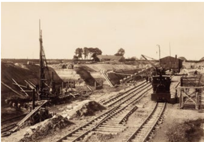
Budowa Śluzy Północnej, 1893, widoczne m.in. palownice parowe
