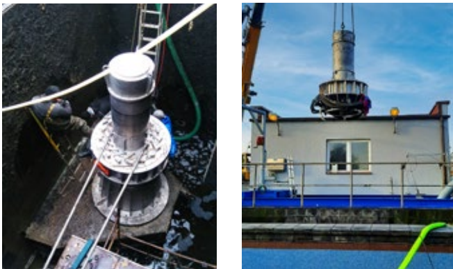
Turbina na wylocie ścieków oczyszczonych w trakcie prac przeglądowych
