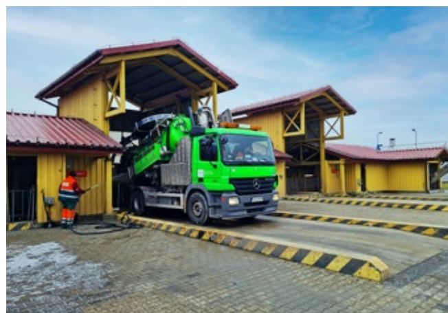
Jeden z obiektów planowanych do ogrzewania ciepłem odpadowym
