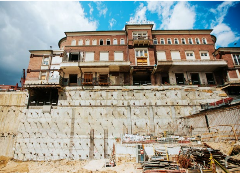
Widok na żelbetową ścianę dociskową na budowie Teatru Polskiego w Szczecinie
