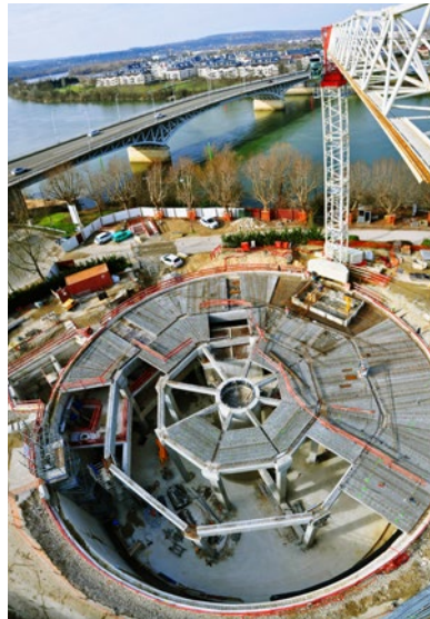
Budowa zbiornika magazynowego Poissy Bridge o pojemności 8100 m 3
