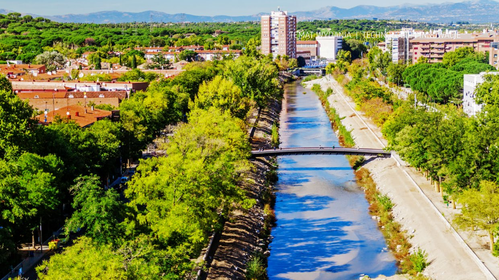
Kładka dla pieszych z materiałów kompozytowych na bazie polimerów zbrojonych włóknem. Obiekt o imponującej rozpiętości 45 m i szerokości 3,5 m znajduje się w Madrycie i został zrealizowany przez międzynarodową spółkę specjalizującą się w nowoczesnych rozwiązaniach dla budownictwa, fot. Matyas Rehak, Adobe Stock
