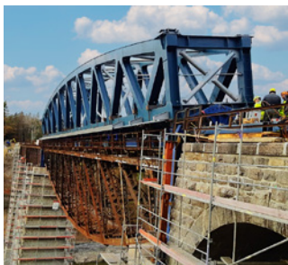
Ryc. 10. Początek obrotu nasuniętego przęsła [14]
