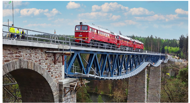
Ryc. 13. Próbné obciążenie mostu z użyciem trzech lokomotyw T679 o masie 116 t [14]
