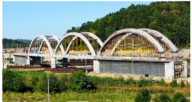
Ryc. 4. Budowa mostu kolejowego w Tarnawie Dolnej w Małopolsce z wykorzystaniem rusztowań stacjonarnych [11]
