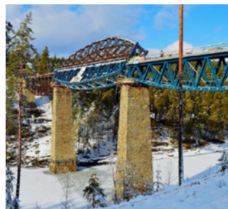
Ryc. 11. Przęsło środkowe w fazie obracania [14]
