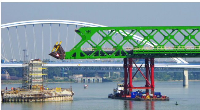
Ryc. 6. Podpora pływająca w czasie podłużnego nasuwania przęseł mostu w Bratysławie [13]
