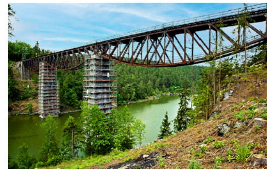
Ryc. 8. Most podczas remontu kamiennych filarów [14]
