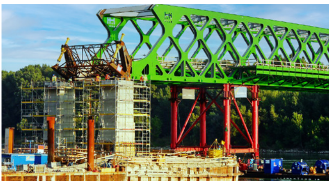
Ryc. 7. Hydrauliczny dziób montażowy [13]
