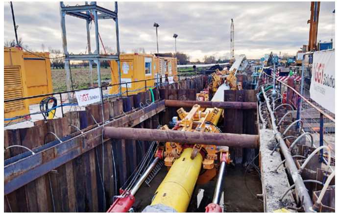
Komora nadawcza z zainstalowanymi dwiema stacjami pchającymi Pipe Thruster
