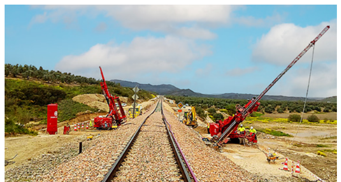
Wykonanie wzmocnienia nasypu kolejowego z wykorzystaniem technologii Springsol
